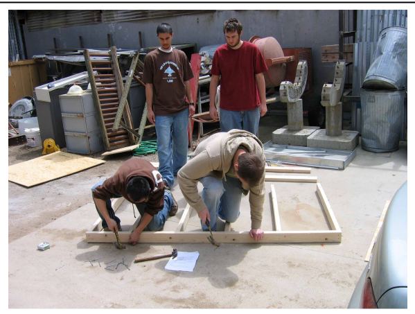
Fig. 4a: Wall Framing
